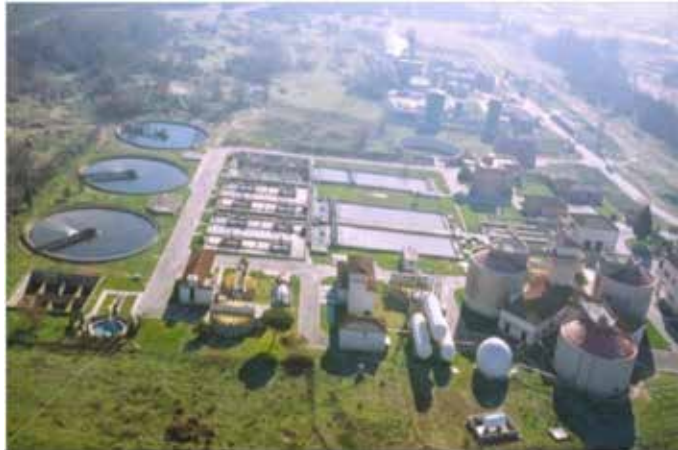
Vista aérea de la estación depuradora de aguas residuales de Valdebebas (Madrid).
