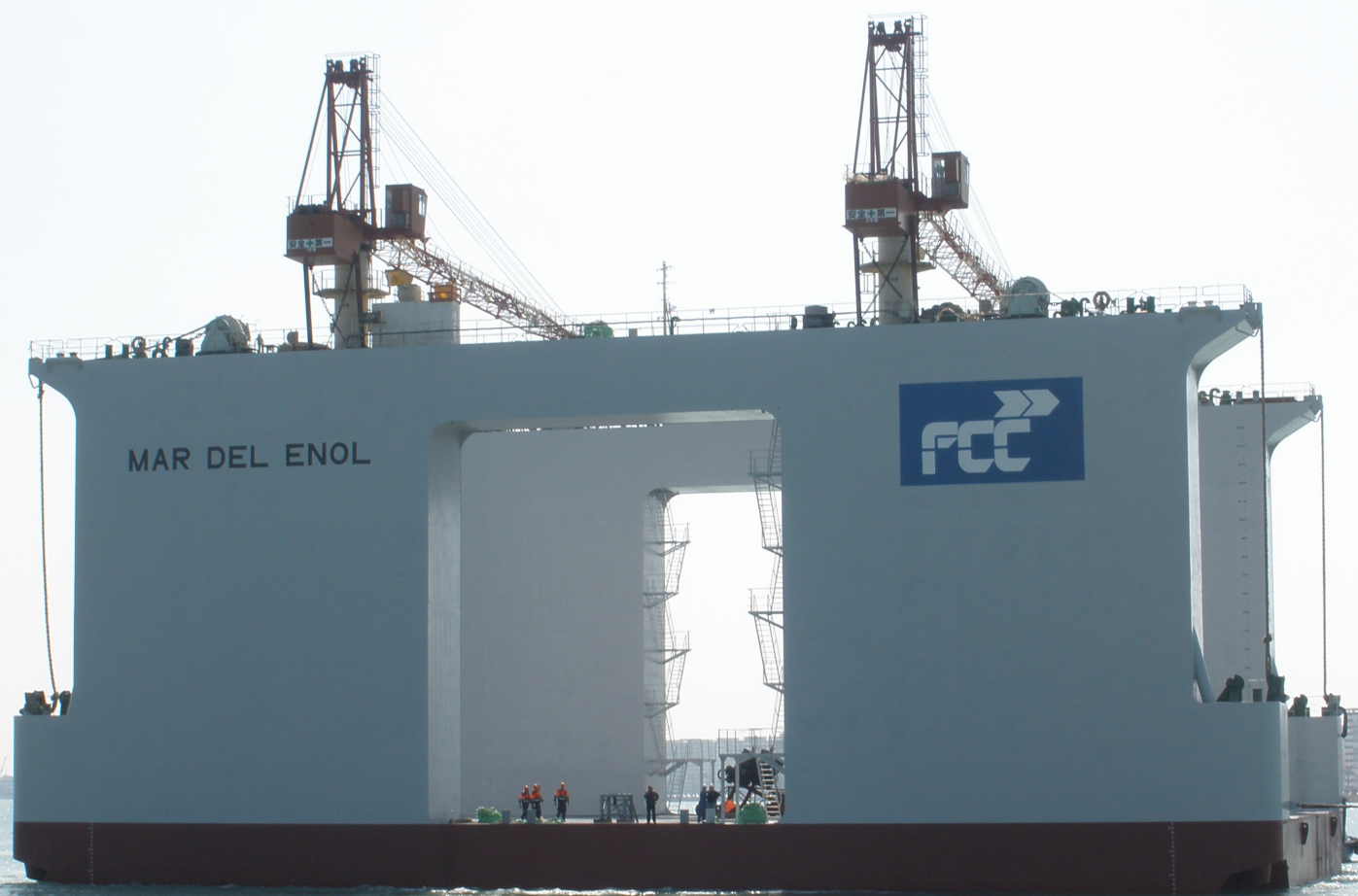
El dique flotante Mar del Enol fue estrenado para fabricar los cajones del puerto de Açu (Brasil).
